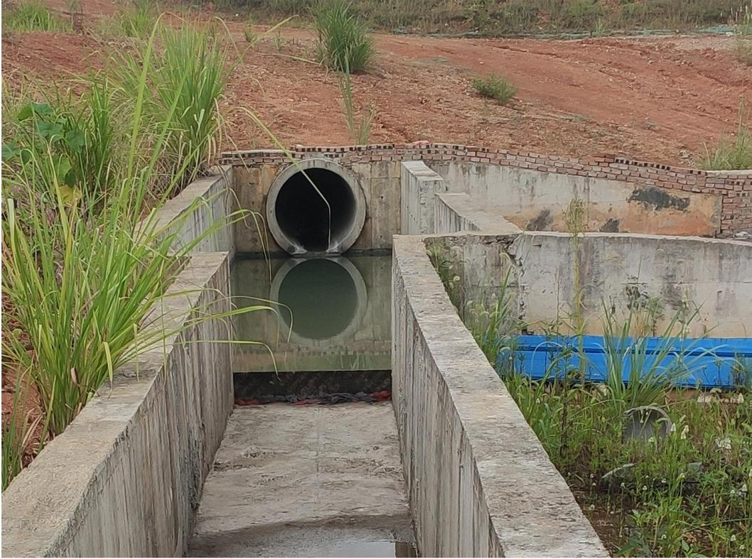
图 2-7 排水涵管出水口、消力池
